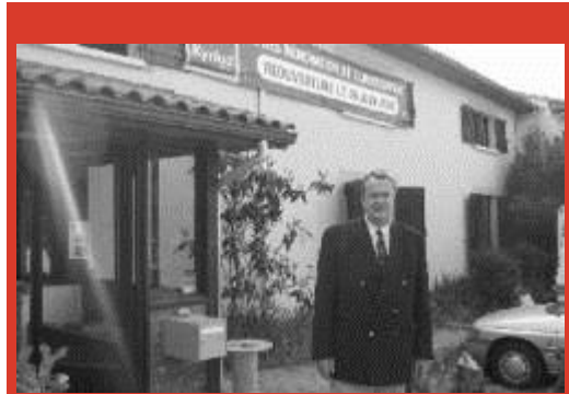
Christian Cormouls-Houlès sur le chantier de l'hôtel Kyriad qui ouvrira ses portes le 26 juin prochain PHOTO J-P.T.
